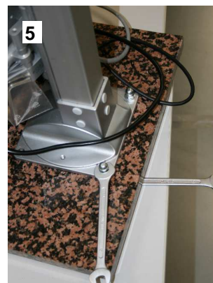
Anschrauben der Muttern auf die Schrauben
